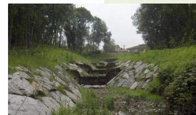
Il progetto consiste nei lavori di protezione del collettore con ricostruzione dell'alveo del rio Valle Domo e consolidamento delle scarpate sede stradale S.P. n.1 in Comune di Buguggiate.
