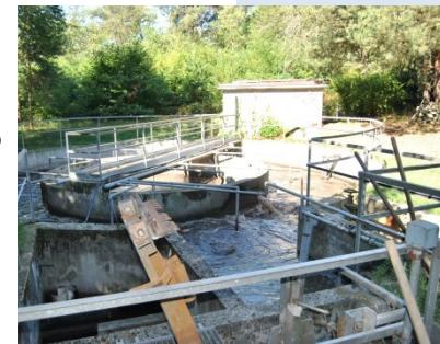
L'intervento di ristrutturazione comporta il rinnovo delle Gli apparecchiature elettromeccaniche di alcune sezioni importanti dell'impianto, come possono essere i pretrattamenti ed il sistema di diffusione dell'aria in ossidazione, e di introdurre nuove fasi, come possono essere lo scomparto di denitrificazione, quello di filtrazione finale e la disinfezione tramite lampade U.V.
