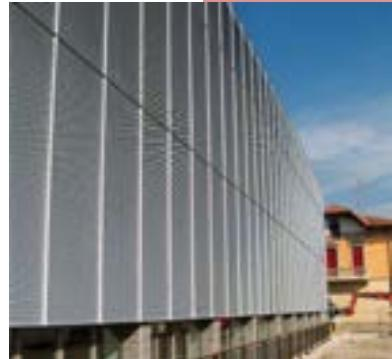
Il progetto si propone di adeguare l'involucro edilizio con la realizzazione di un sistema di facciata che coibenta le strutture dall'esterno rivestendo l'edificio con lastre di lamiera stirata. Il progetto prevede di mantenere continua la lamiera anche dinanzi ai serramenti, utilizzando la lamiera come frangisole per tutte le finestre. La ristrutturazione comprende la realizzazione di impianto solare termico in copertura e la predisposizione per impianto fotovoltaico.
