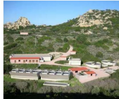
L'obiettivo del progetto è il risanamento delle acque dell'intero territorio della Località Costa Paradiso, riqualificazione ambientale ottenibile grazie al collettamento di tutti i reflui, ad un sistema di trattamento depurativo centralizzato con l'ampliamento del depuratore esistente ed all'eliminazione delle dispersioni nel suolo delle singole fosse Imhoff private.
