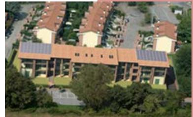
Le facciate sono caratterizzate dall'alternarsi di intonaco e mattone la facciata sud è definita da ordini giganti di pilastri in mattoni. L'edificio è dotato di sistema di produzione del calore centralizzato realizzato con pompa di calore collegata a sonde geotermiche. Uno degli obiettivi dell'operazione è la certificazione delle prestazioni energetiche secondo standard di alta efficienza.
