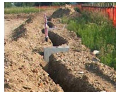
L'intervento consiste nella realizzazione del sistema di collettori comunitari per la raccolta delle acque reflue da addurre all'impianto di depurazione comunitario "Bolletta" in Comune di Cuasso al Monte (VA), della stazione di sollevamento e della relativa condotta in pressione per l'adduzione delle acque reflue del comune di Porto Ceresio all'impianto di depurazione comunitario "Bolletta" in Comune di Cuasso al Monte (VA) e del sistema di telecontrollo.
