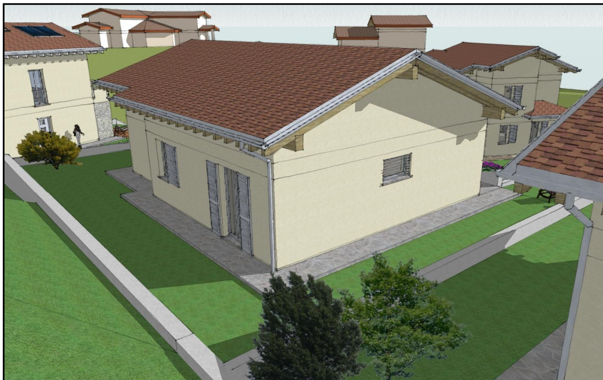
LOTTO F - VISTA DA NORD - OVEST
